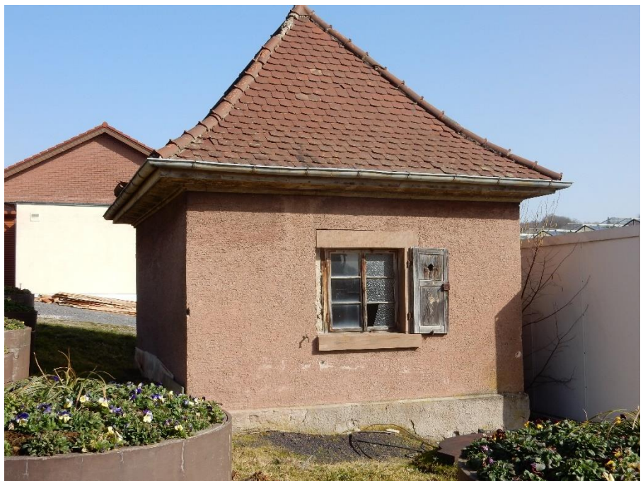
Foto 3: Kleines Häuschen im Untersuchungsgebiet mit Habitatpotenzial für Vögel und Fledermäuse.
