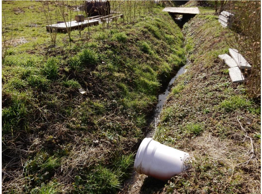
Foto 6: Südlich der Gewächshäuser verläuft ein weiterer Graben, der wenig Wasser führt und dem aus verschiedenen Rohren Wasser zugeleitet wird.
